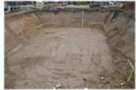
Aushub der Baugrube in der erforderlichen Tiefe, einschließlich eines Arbeitsraumes und seitliche Lagerung des Materials.
