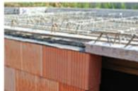
Geschossdecken in Stahlbeton, ca. 20 cm stark (bzw. nach statischer Berechnung), mit Sichtbetonunterseiten (Filigrandeckenplatten), Stöße gespachtelt (nicht tapezierfähig).
