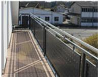
Stahlstabskonstruktion mit Ober- und Untergurt, Konstruktion nach Wahl des Bauträgers, feuerverzinkt, kein Anstrich.
