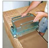
Alle Arbeits- und sonstigen Fugen werden durch Einlegen von Stahl- bzw. Gummibänder abgedichtet.
