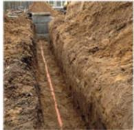
Anschluss an den Straßenkanal mit Revisionsschacht bis zur Grundstücksgrenze.
