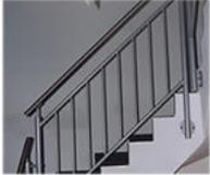
Stahlstabskonstruktion mit Ober- und Untergurt, sowie senkrechten Füllstäben, grundiert und gestrichen. Handlauf nach Wahl des Bauträgers.
