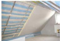
Die Dachschrägen und Flachdächer in den Wohnbereichen werden unterhalb der Sparren und Balken mit Gipskartonplatten, d= 12,5 mm, verkleidet.
