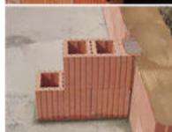
Wohnungstrennwände, einschalig 24 cm stark (bzw. nach Schallschutzberechnung).
